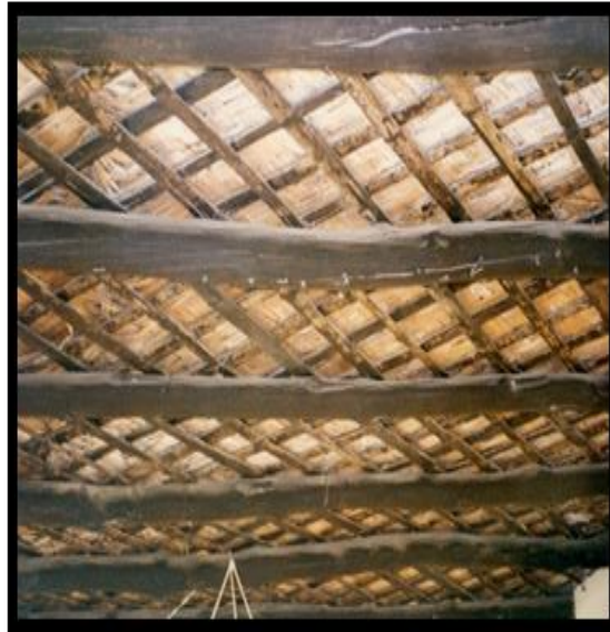
شكل رقم (٤) أحد الأسقف الداخلية ويظهر ترتيب أجزاء الجندل ثم خشب الاسجيل ثم البواري (الحصير)
