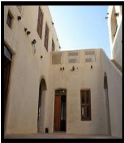
شكل رقم (٣) يظهر البروز الخشبي والمسمى الجندل وهو امتداد خشب السقف
